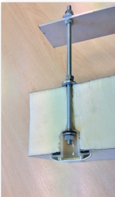
Podwieszenie płyty sufitowej na pręcie gwintowanym bezpośrednio do konstrukcji
